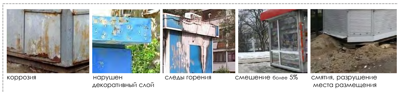
рис. 1.2 «пример визуально определяемых деформаций, при наличии которых определяется невозможность использования НТО по назначению»
